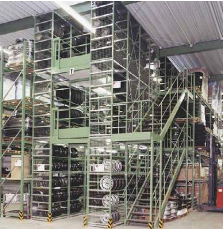
3-geschossige Fachbodenregalanlage mit Treppenaufgang. Branche: KFZ-Teilehandel
