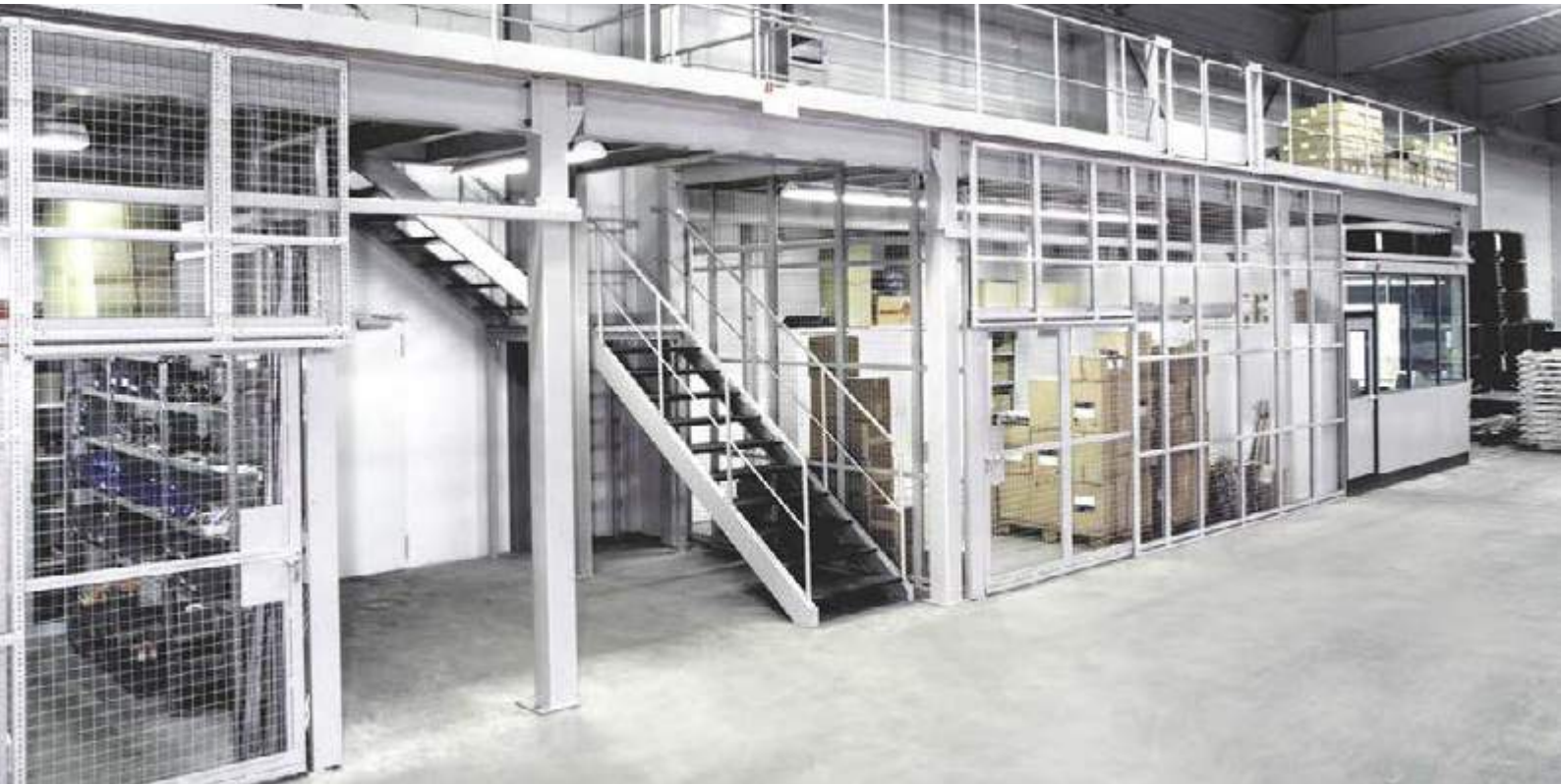
Lagerbühne mit Hallenbüro, Gitterzaun, Schutzgeländer und Übergabeplatz
