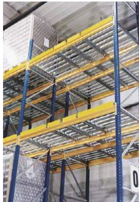
Palettenregal-System mit integrierten Rollenbahnen als Einschubregal. Branche: Folienherstellung
