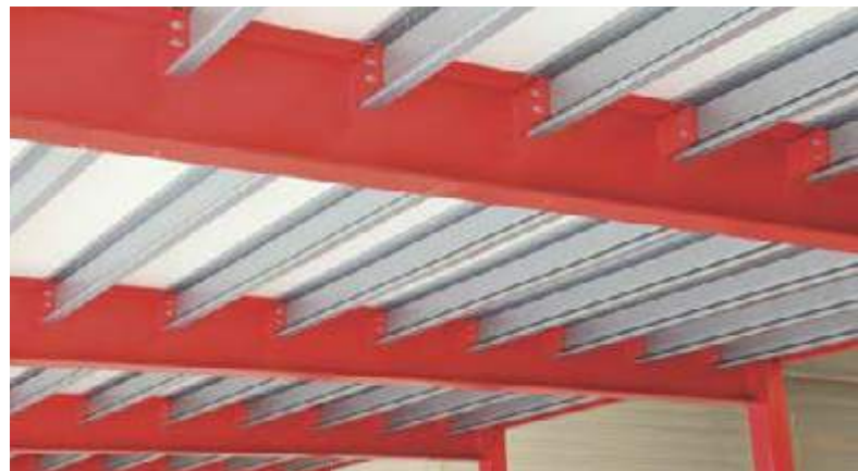
Detailfoto: Bühnenträger aus verzinkten Sigma-Profilen
