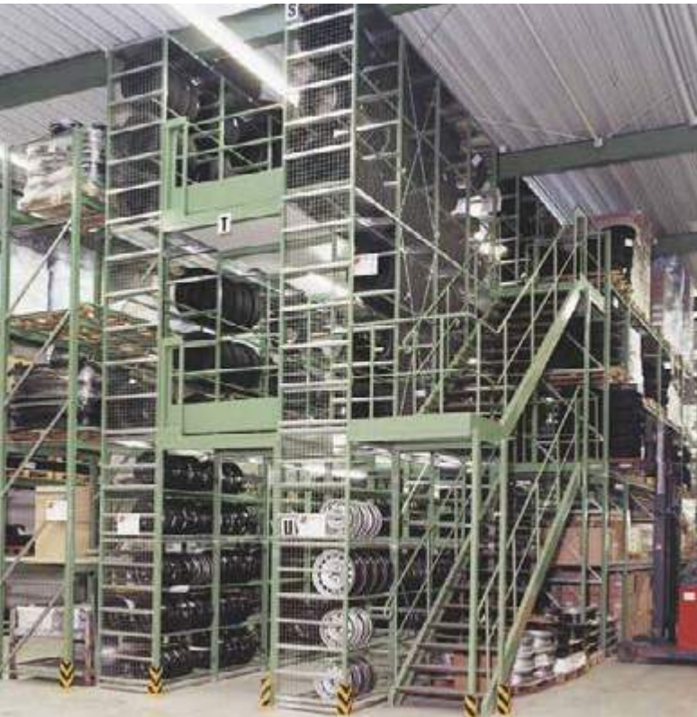
3-geschossige Fachbodenregalanlage mit Treppenaufgang. Branche: KFZ-Teilehandel
