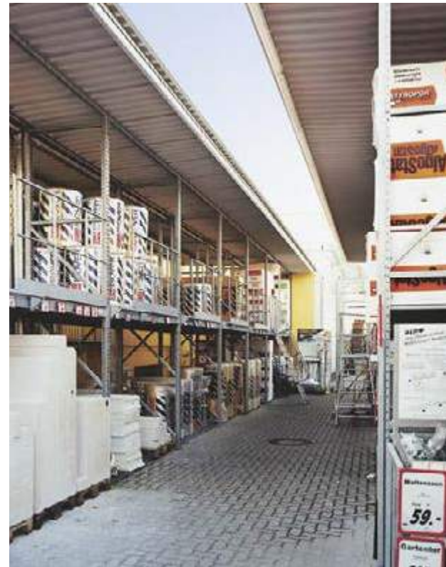
Mehrplatz-Palettenregal Außenaufstellung mit Dacheindeckung.
