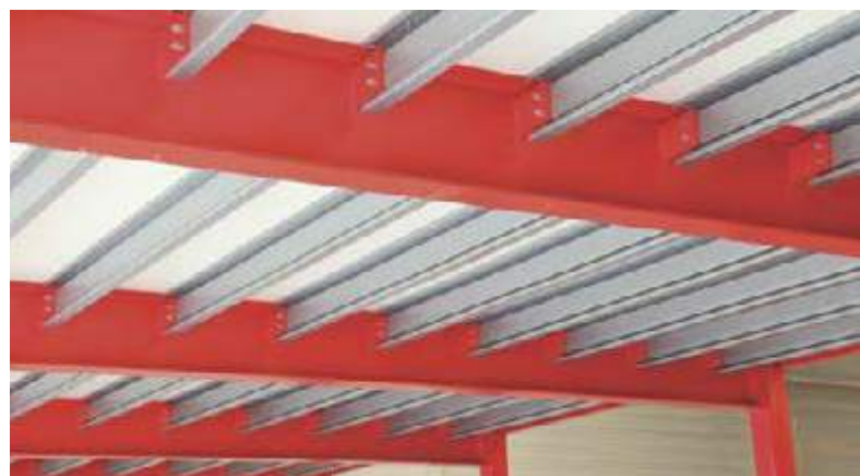
Detailfoto: Bühnenträger aus verzinkten Sigma-Profilen
