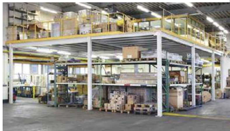
Lagerbühne mit Schutzgeländer und Meisterbüro
