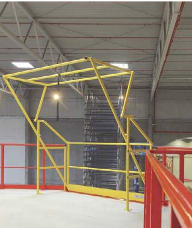
Detailfoto: Übergabeplatz mit Sicherheits-Schwenkgeländer
